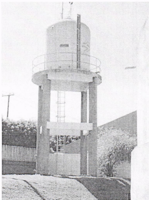
FIGURA 56 – RESERVATÓRIO ELEVADO CAPACIDADE 25 M 3 - RUA PORTUGAL
