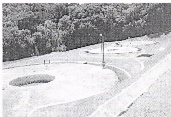
FIGURA 97 – VISTA DOS RALF (REATORES ANAERÓBIOS DE LEITO FLUIDIZADO)
