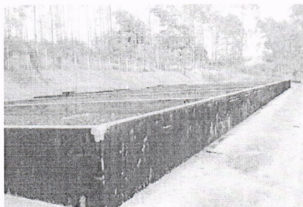
FIGURA 89 – VISTA DO LEITO DE SECAGEM COM 8 COMPARTIMENTOS
