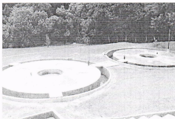
FIGURA 98 – RALF (REATOR ANAERÓBIO DE LEITO FLUIDIZADO)
