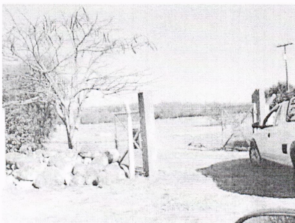
FIGURA 18 – ACESSO AO MANANCIAL SUPERFICIAL DE CAPTAÇÃO
