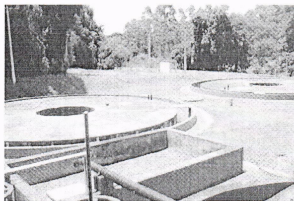
FIGURA 83 – RALF (REATOR ANAERÓBIO DE LEITO FLUIDIZADO) 1 E 2
