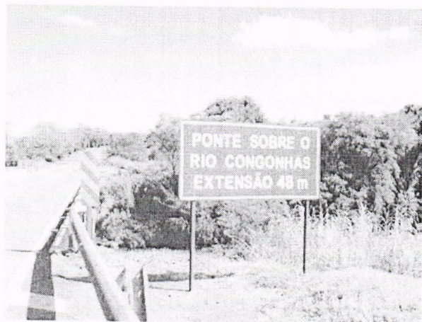
FIGURA 15 – BR 369 SOBRE RIO CONGONHAS – MONTANTE À CAPTAÇÃO
