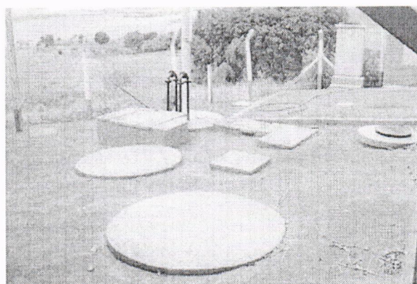
FIGURA 62 – ESTAÇÃO ELEVATÓRIA DE ESGOTO EEE07
